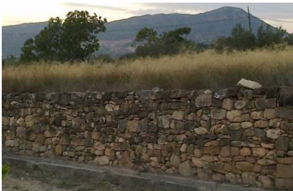
Fig. 4. Horma que sustenta el bancal (detalle). Foto del autor.
